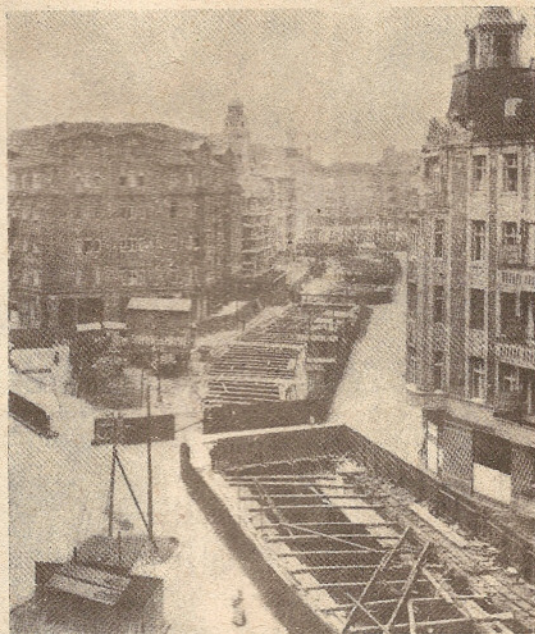
V letech 1908-1910 budovala firma Siemens & Halske podpovrchovou dráhu v Berlíně. Stavba, která velmi připomíná svým vzhledem Prahu 1967 měla vlastní elektrárnu, „aby pneumatická zařízení nerušila okolí“. Dráhu stavělo průměrně 500 lidí, tři kilometry délky jim trvaly necelé dva roky.
